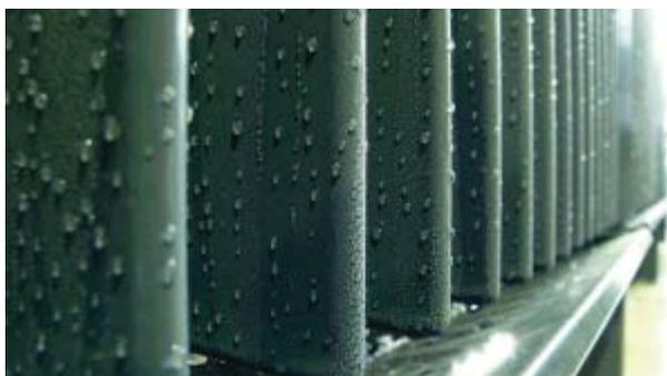
写真1 ラジエータ表面の結露の様子
