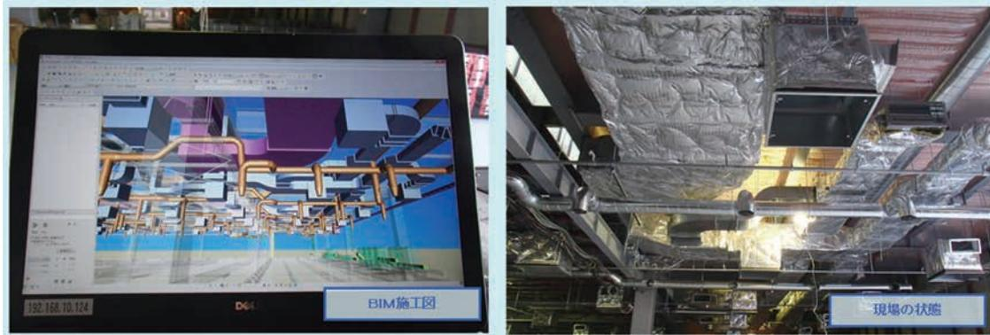
（写真－3） BIM施工図による工事監理
