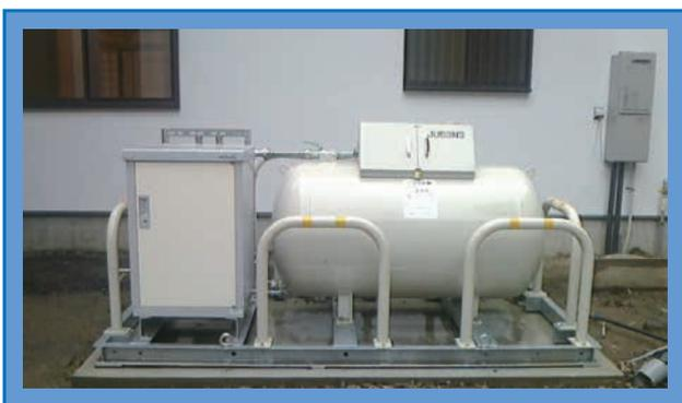
災害対策バルク（タンク左のBOX内）にガス取出口が設けられており、タンク内の残ガスを炊出し等に使用出来る仕組みになっている。
