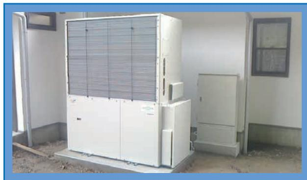
自立型発電機能付GHP（ガスヒートポンプエアコン）停電時も自立発電機能により、一部の空調を使用でき、尚且つ電灯やコンセントの一部使用も可能となる空調機。災害対策バルク（左上写真）とのコンビで、災害時の非難場所としての活躍が期待出来る。
