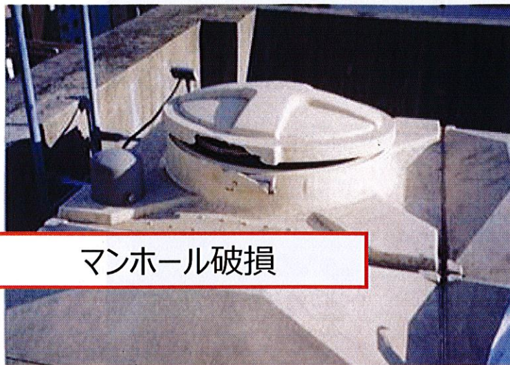
配管接続部とマンホール破損
