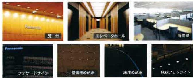
汐留シオサイトやビル内の各所にLED照明を採用しています。
