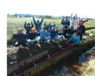
魚のゆりかご水田プロジェクト FFU 端材を活用した魚道設置
