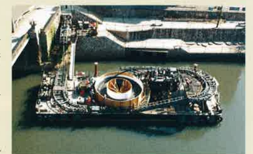
堀川交差点でのケーブル設置工事
