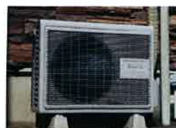
空気熱源ヒートポンプ
