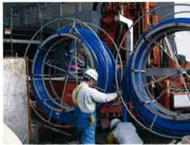
Uチューブ設置状況
