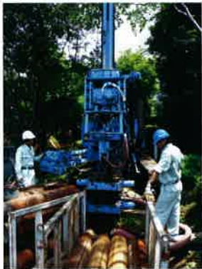
地中熱交換井の掘削状況
