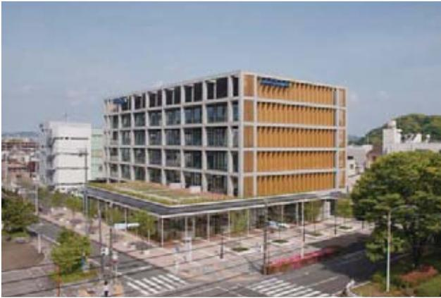
静岡ガスの本社ビルが2013年3月に完成した。設計管理は日建設計、施工は清水建設が担当、13ヶ月という規模からすると非常に短い工期で竣工した。地上6階建て、延床面積7,500㎡、建物構造はSRC造（一部鉄骨造）のダブルコラム構造を採用した。各フロアでは50m×21mの無柱空間を創出している。コンクリート打放しと木製ルーバーの調和が取れた外観が印象的な建物である。また制震構造を採用し、制震ダンパーにより地震エネルギーを吸収、建物の揺れを軽減している。津
