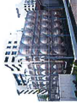
SUSパネル型水槽（溶接組立）
